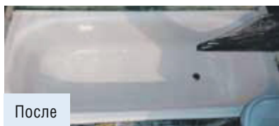
До После Материал высыхает за 36 часов, после чего ванной можно пользоваться
